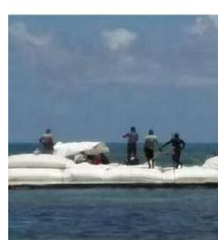
Arrecife de Concreto
